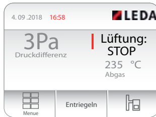
Abb. 7.4 Anzeige bei einer Störung
